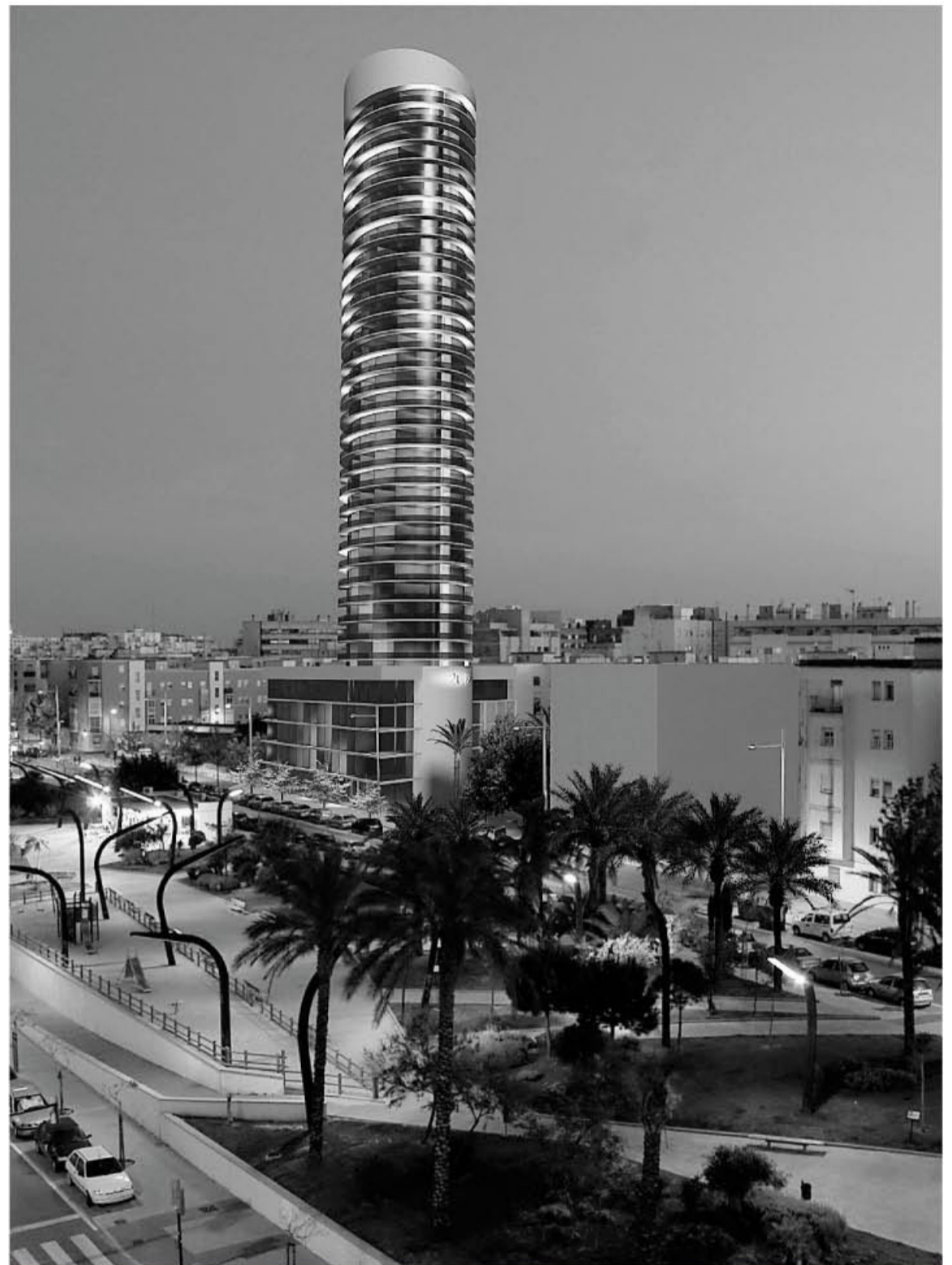
Propuesta de edificio a la altura en la Avda. Juan Carlos I de MCK Arquitectos y Juan A. de la Mata.
