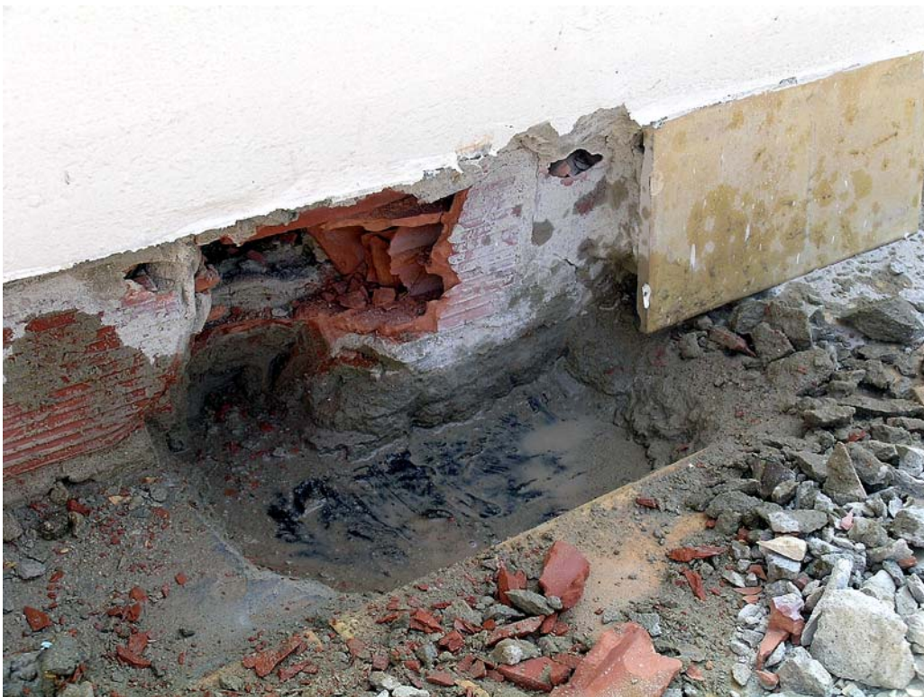
Cata en la cubierta del ático
